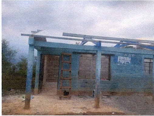
Foto 3: Fotografía frontal de cocina.
