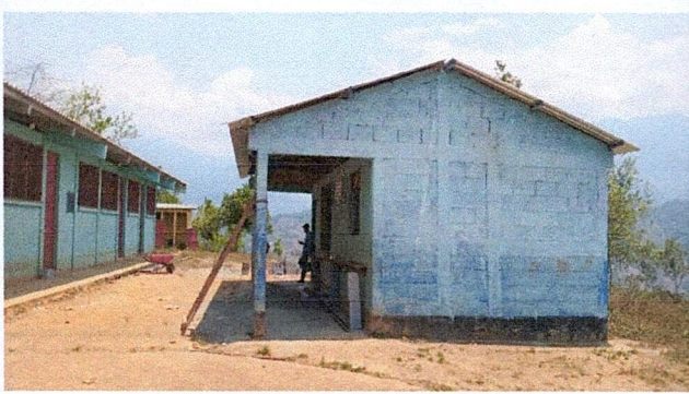
Foto 1: Fotografía de aula y cocina.
